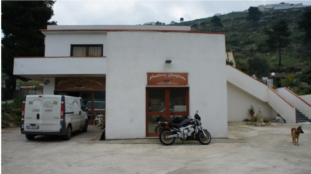
Figura 1: Vista esterna -prospetto sud
